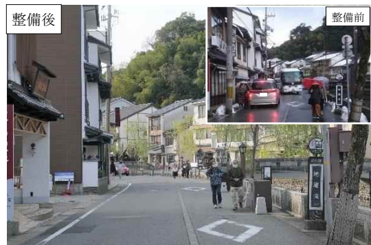
無電柱化対策
