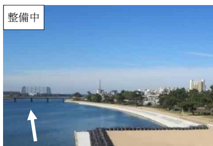
河川改修（護岸、河床掘削等）
