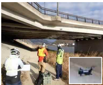
橋梁点検(ドローン撮影)
