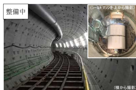
河川改修（地下貯留管）
