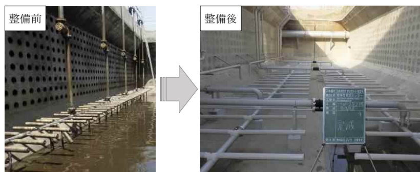
老朽化した散気装置を更新
