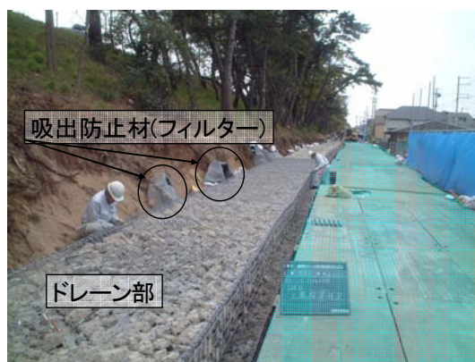
写真 2.2.4 堤防強化工事の例（ドレーン工）
