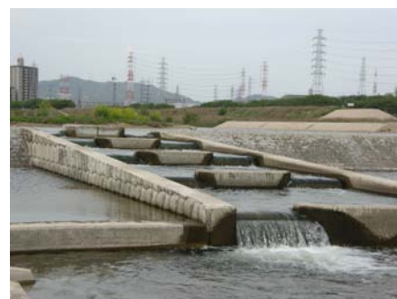
写真 2. 2. 20 床止めに設置された魚道
