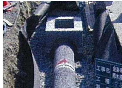
写真 2. 2. 11 浸透側溝
