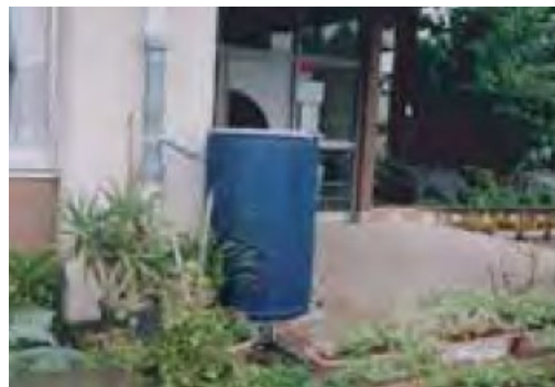
図 5-2.2 各戸貯留施設の例(地上タイプ)
