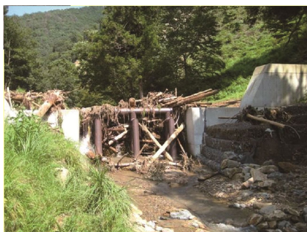
写真 5-7-2 H21 年災害時における砂防堰堤の効果事例（佐用町下石井）
